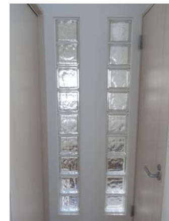
1階玄関と廊下を仕切るガラ スブロックで採光確保。
